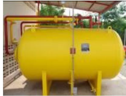
ระบบโฟมดับเพลิง (Fixed Foam System)
