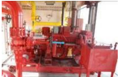
ระบบปั้มน้ำดับเพลิง (Fire Pump) จำนวน 2 ชุด
